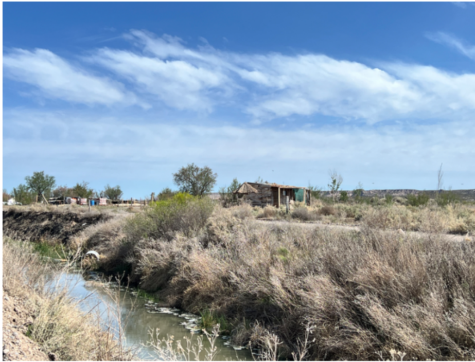
Figura 5.10. Derrame hacia el río Colorado de líquidos cloacales a cielo abierto y sin tratamiento en la localidad de 25 de Mayo.
